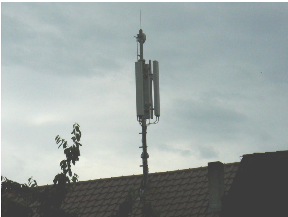
Bild 2: Anlagenstandort von Messpunkt 1 aus gesehen
